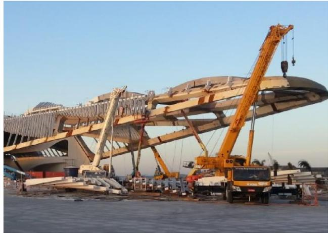
**Figura 07:** Vista do Museu do Amanhã após descimbramento e retirada das escoras. Cobertura em fase final de montagem – Data: 05/04/15.
