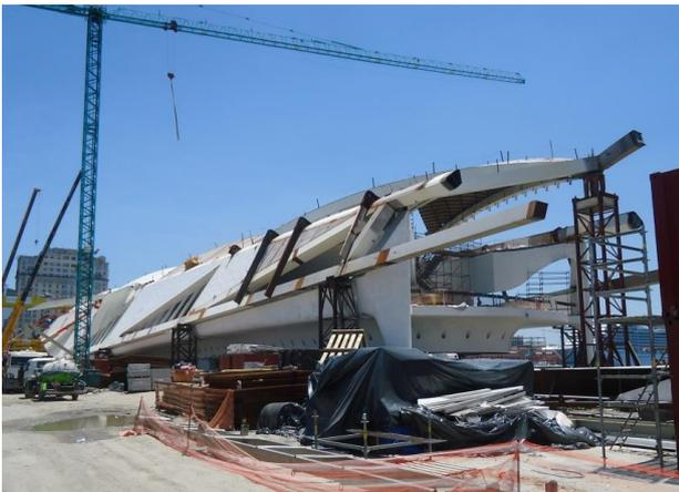
**Figura 08:** Vista do balanço lado mar do Museu do Amanhã, ainda em fase de montagem – nota-se a montagem de algumas escoras – Data: 10/01/15.
