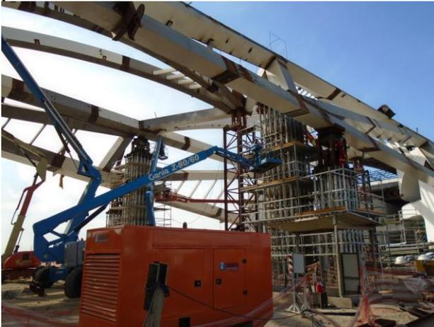
**Figura 06:** Vista parte da estrutura do Museu do Amanhã do lado terra, no momento do descimbramento – Data: 20/02/15.
