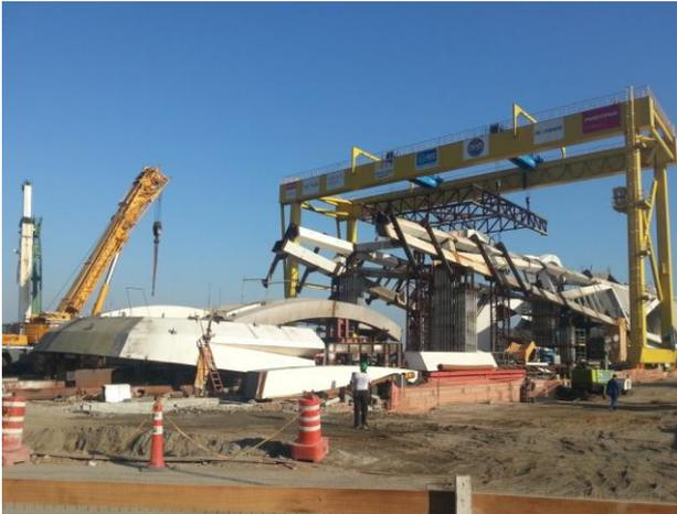
**Figura 04:** Vista do balanço lado terra sendo montado com parte da cobertura ainda no chão e parte do cimbramento montado – Data: 10/01/15.
